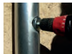
Un seul trou suffit. Pas besoin de sectionner la gouttière
