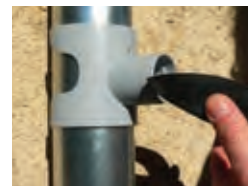
Clipsage du collier et mise en place de l'écope
