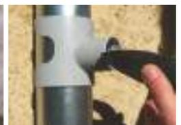
Clipsage du collier et mise en place de l'écope
