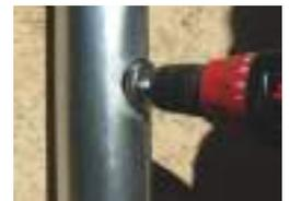
Un seul trou suffit. Pas besoin de sectionner la gouttière
